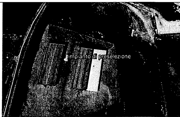
Edificio Impianto di preselezione rifiuti
