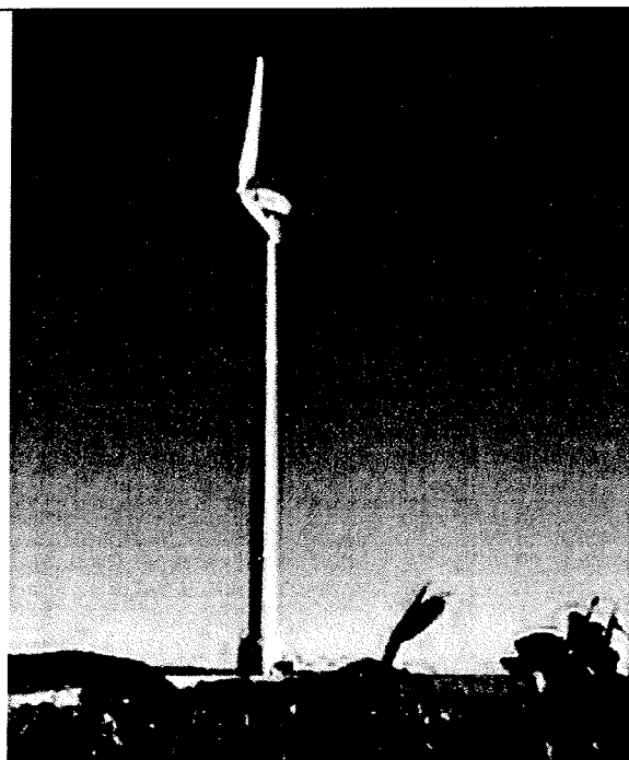
Esempio turbina minieolica da 60 kW
