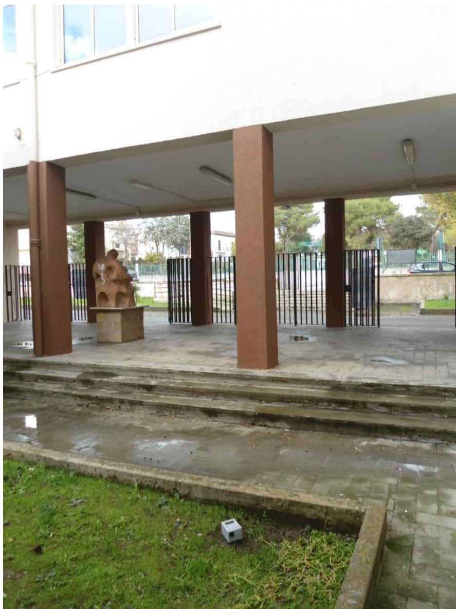
Foto 3 – Indagine HVSR condotta nell'atrio interno della scuola.
