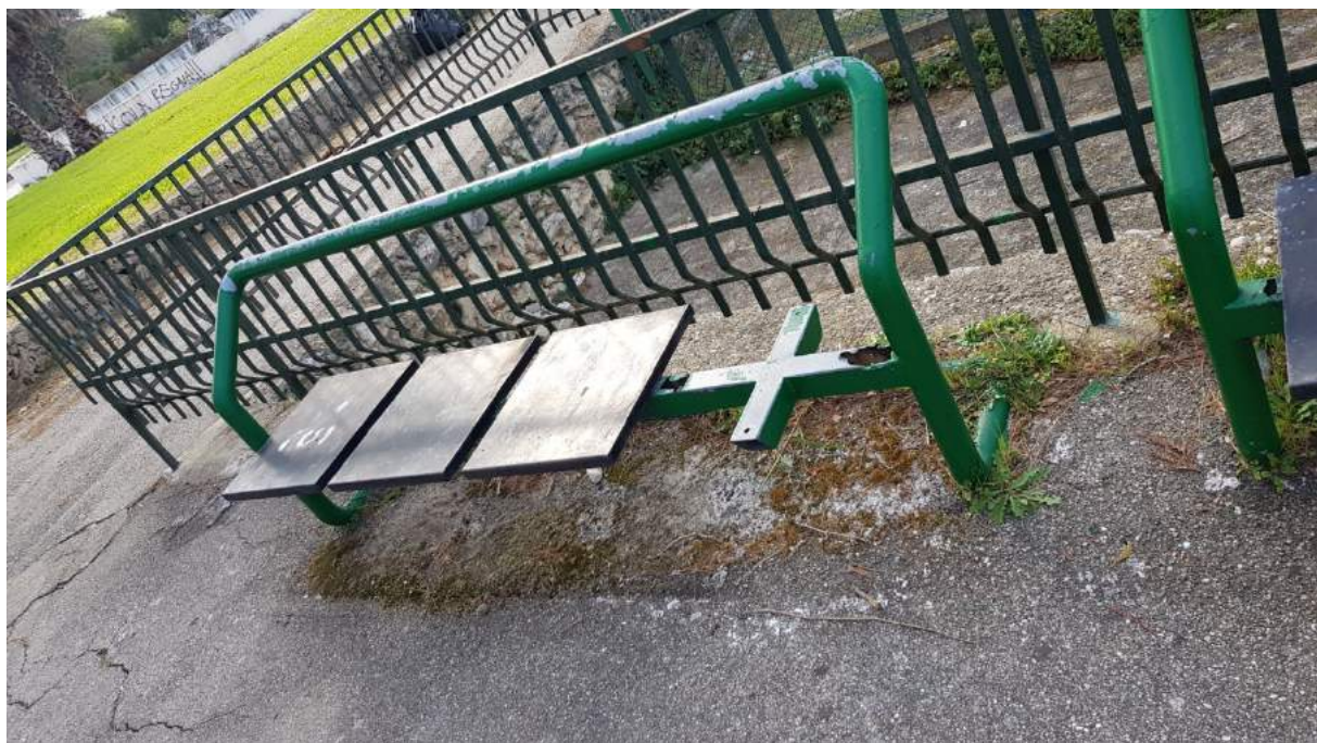
Figura 19 vista dello stato di degrado delle panchine
