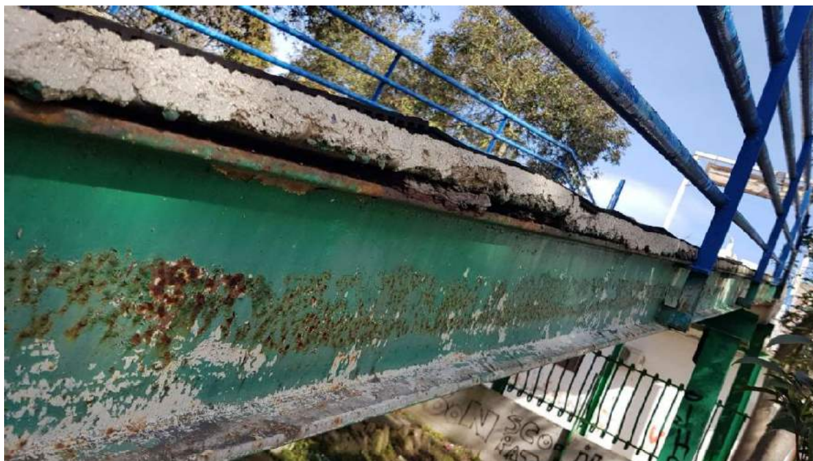
Figura 3 vista scala_particolare struttura portante in ferro
