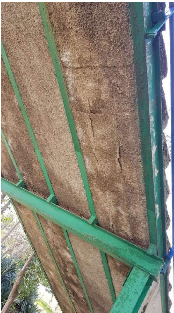
Figura 5 vista scala_particolare solaio in latero-cemento e struttura in ferro
