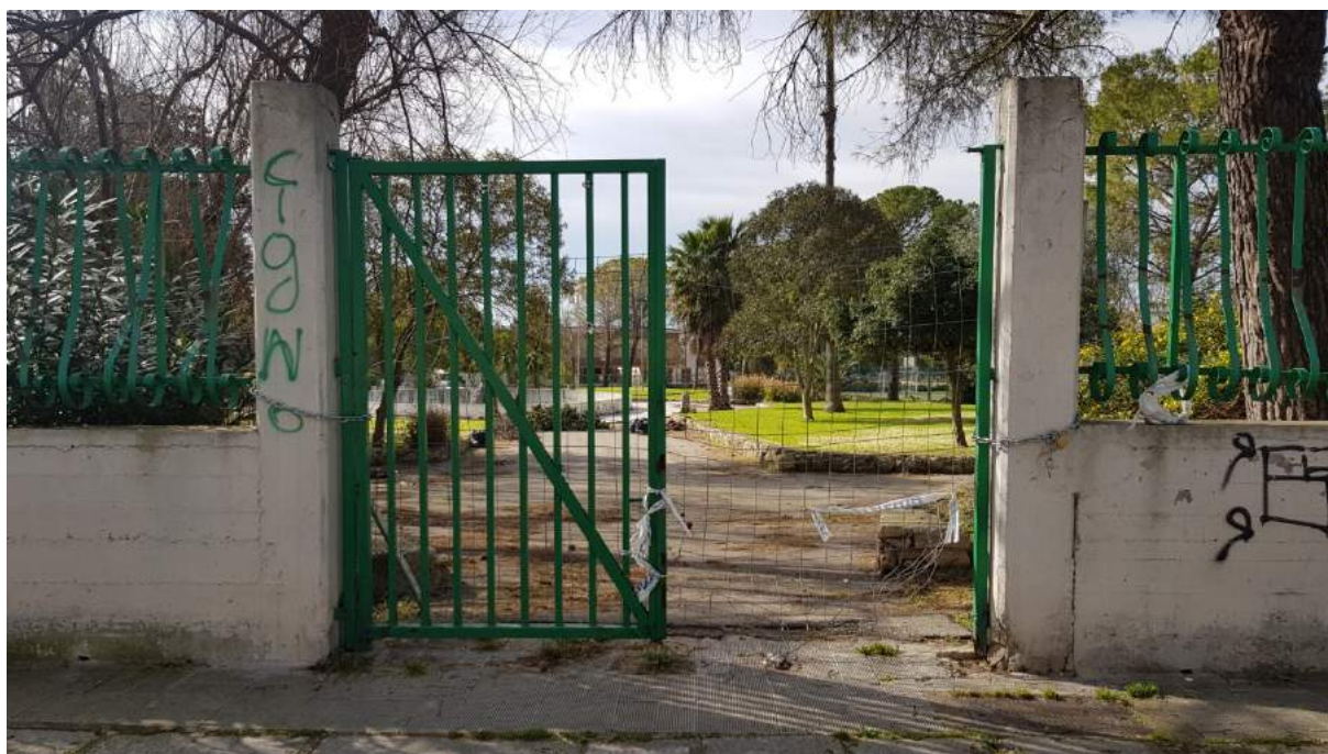
Figura 7 vista del cancello su via Pirandello (un'anta è mancante)
