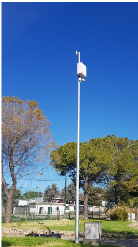
Figura 16 vista del palo supporto telecamera di video-sorveglianza
