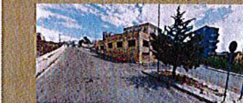
Vista dell'area di intervento da via Tedesco
