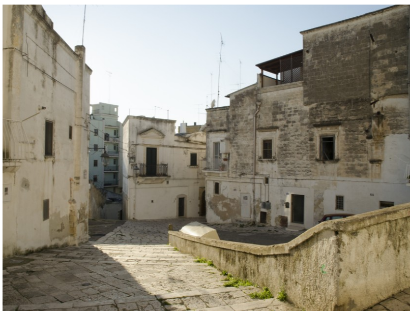
Foto 46 e 47 - intonaci costituiti da malta a base di calce con inerti di coccio pesto o sabbia di tufo, usati per regolarizzare superfici murarie al piano stradale assenti nei piani superiori
