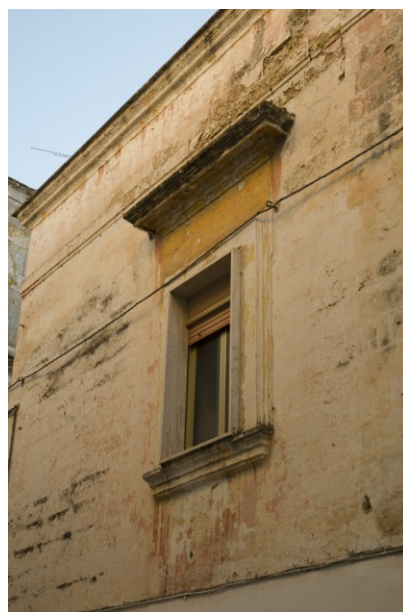
Foto 46 e 47 - intonaci costituiti da malta a base di calce con inerti di coccio pesto o sabbia di tufo, usati per regolarizzare superfici murarie al piano stradale assenti nei piani superiori
